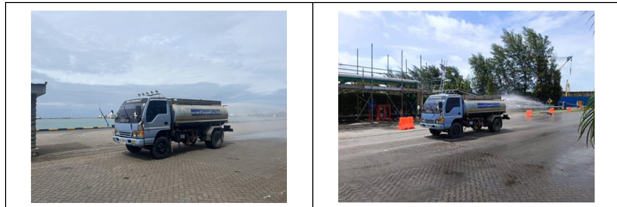
รูปที่ 1 การฉีดพรมน้ำบริเวณพื้นที่ก่อสร้าง
